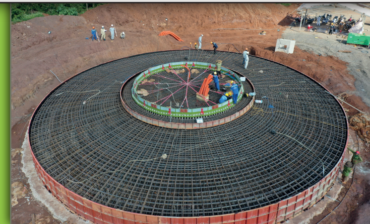
Bau eines Betonfundaments für ein Windrad
